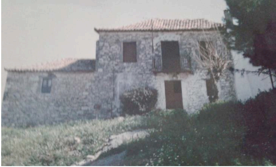
Εικόνα 4: Λιθόκτιστη παραδοσιακή κατοικία στο Πεταλίδι, ιδιοκτησίας Αικατερίνης Μαρτάκου
