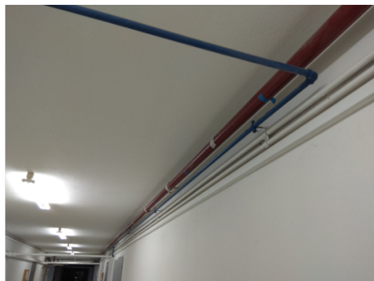
Εικόνα 2. Αριστερά: Σωληνώσεις πόσιμου νερού (μπλε) και πυρασφάλειας (κόκκινο), τμήματα A1-A2 και B1-B2. Δεξιά: Σωλήνας πυρασφάλειας (κόκκινο), τμήμα D1-D2.
