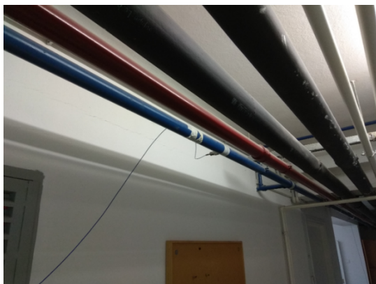
Εικόνα 2. Αριστερά: Σωληνώσεις πόσιμου νερού (μπλε) και πυρασφάλειας (κόκκινο), τμήματα A1-A2 και B1-B2. Δεξιά: Σωλήνας πυρασφάλειας (κόκκινο), τμήμα D1-D2.
